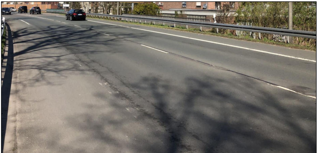
Abbildung 26: Veraltete Fahrbahnmarkierung auf der Hermann-Ehlers-Straße (L 510) (Blickrichtung Westen, 30.03.2021)
