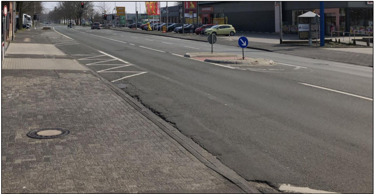
Abbildung 25: Rissige Oberfläche auf der Ochtruper Straße (L 510) (Blickrichtung Osten, 24.03.2021)
